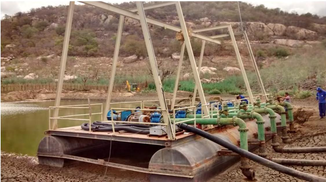
Foto 3: Flutuante pertencente à captação do Sistema Adutor do Congo no açude Cordeiro
